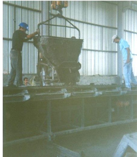
Photo20: Transport du béton par monorail suspendu. Stade Radès
