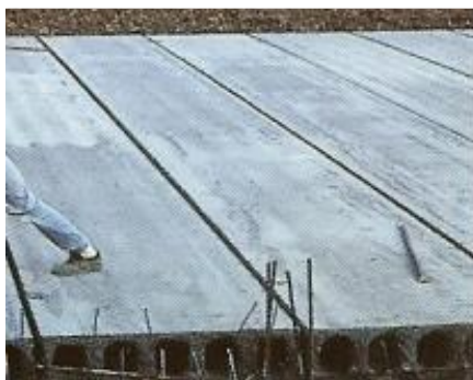
photo21 : préparation des faces assemblage par matage de mortier
