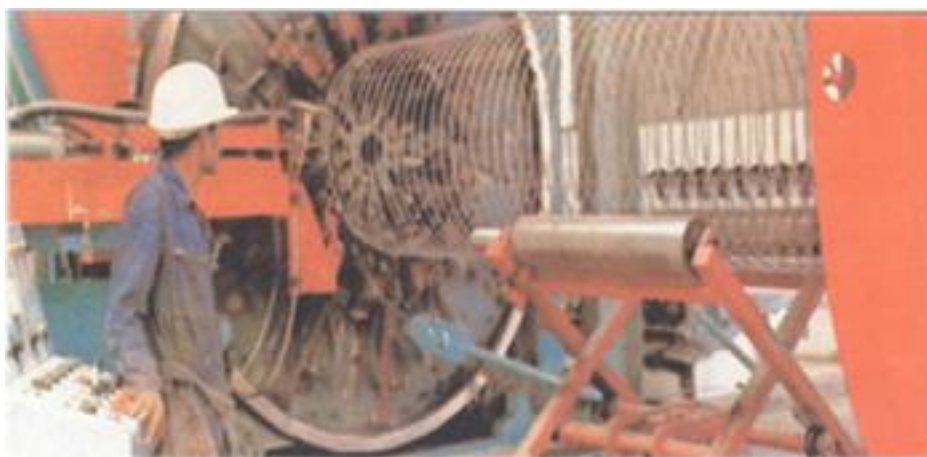
photo22: Ferrailage d'un tuyau
